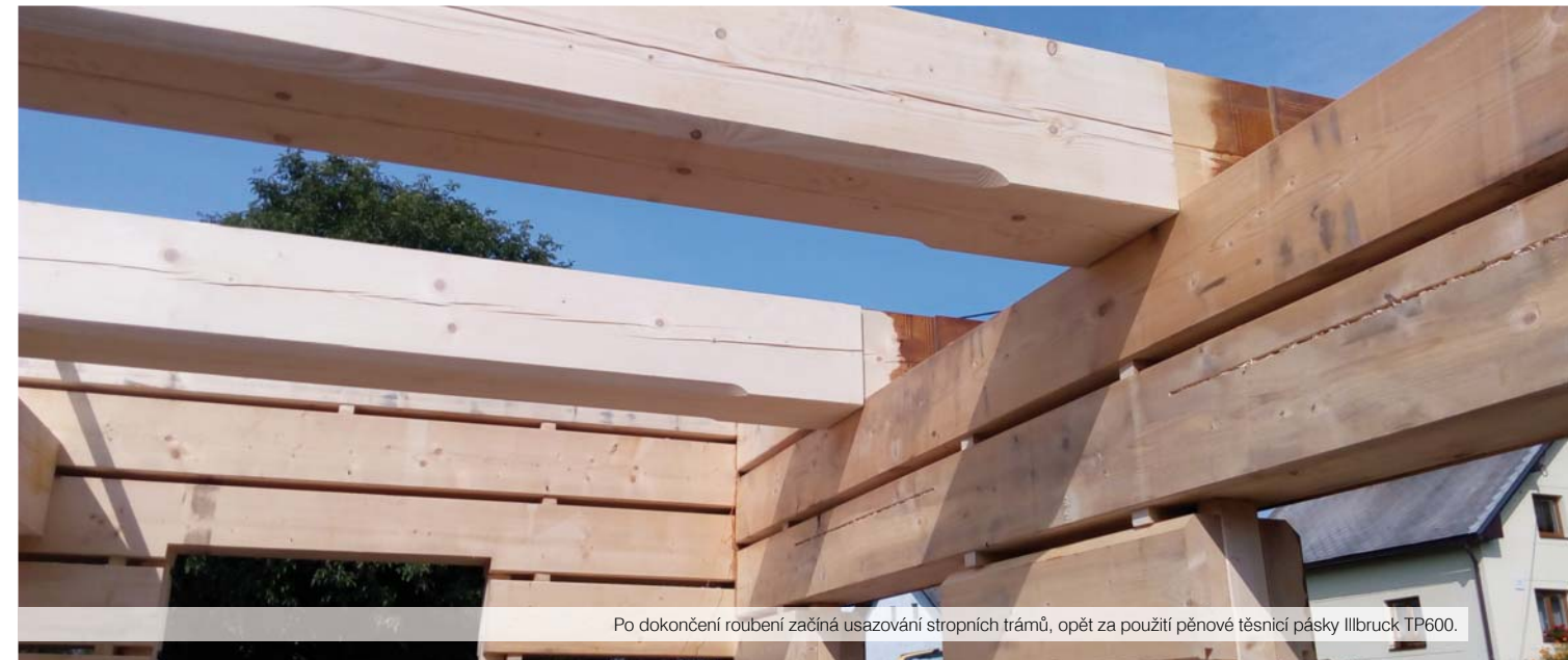
Po dokončení roubení začíná usazování stropních trámů, opět za použití pěnové těsnicí pásky Illbruck TP600.
