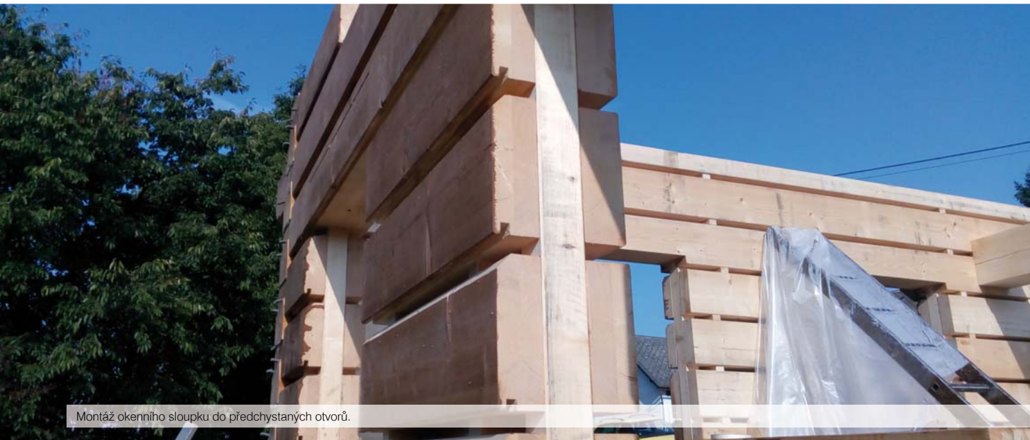
Montáž okenního sloupku do předchystaných otvorů.
